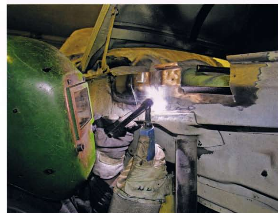
Aufwändig: Verrottetes Blech wird ausgewechselt, eingeschweißt, mit Rostschutzfett behandelt.
