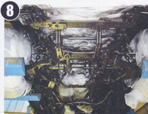
8 Nach drei Sprüh-Durchgängen ist die Beschichtung fertig. Zwischen den einzelnen Arbeitsgängen müssen drei bis vier Stunden Zeit zum Ablüften liegen.
