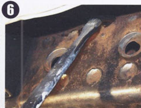
6 Die Vorbehandlung rostiger Teile erfordert nicht den Abschleif bis aufs blanke Blech. Auf die angeraute Oberfläche wird dann COLOR Unterbodenschutz aufgetragen.
