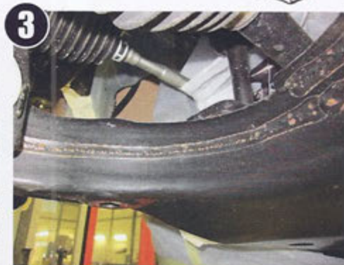
3 Ungeahntes Manko: Der werksseitige Unterbodenschutz. Selbst der frisch vom Band gelaufene Neuwagen zeigt bereits Oberflächenrost an Achsbauanteilen und Rahmen.
