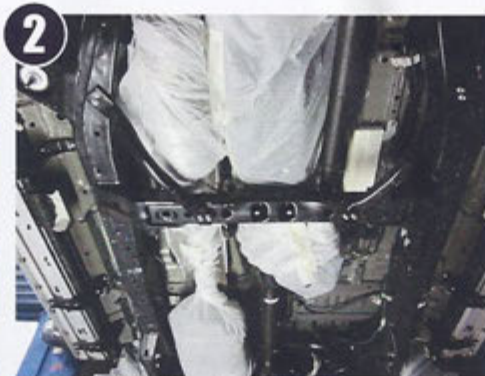
2 Nicht nur die komplette Karosserie wird gegen Sprühnebel isoliert, auch Auspuff, Motor und Getriebe verschwinden unter einer schützenden Folienschicht.
