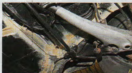
... oder hier an der Schräglenker- und Stabi- Aufnahme hinten. Steht später eine Überholung der Teile an, werden sie wieder vom Fett befreit
