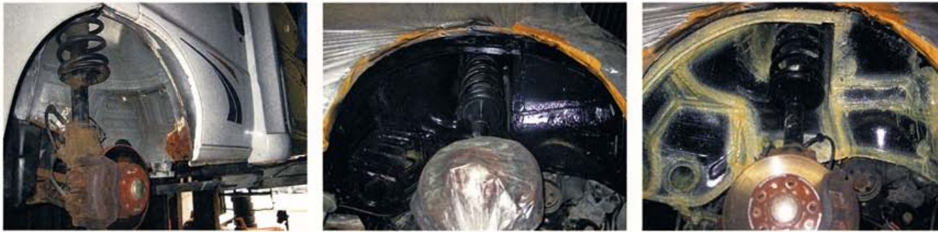
Der Fachmann legt alle Roststellen frei und strahlt sie mit Trockeneis oder Korund. Im Radkasten bildet bereits der schwarze Schutzlack sicheren Rostschutz. Das Fett kommt an gefährdeten Bereichen, etwa an Falzen, zum Einsatz. Im Fahrbetrieb färbt Straßenstaub das helle Konservierungsmittel nach kurzer Zeit schwarz.
