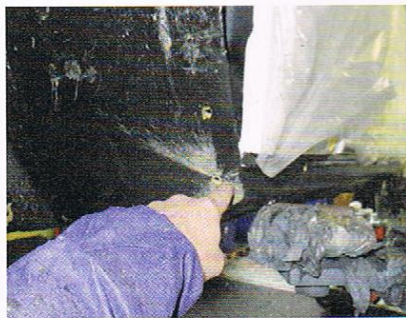
An der Schwellerspitze vorne wird angebohrt und der Schutz dann eingespritzt.
