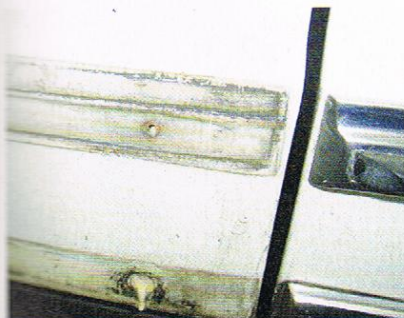
Viele Hohlräume hinter Zierleisten sind relativ leicht erreichbar, auf Bohren kann verzichtet werden.
