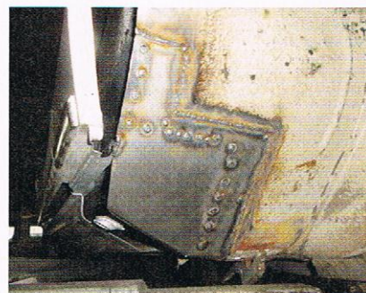
Die Reparaturbleche werden bei TimeMAX wegen der Rostgefahr nicht überlappend, sondern «auf Stoss» eingeschweisst.
