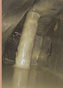
Die erste Schicht TimeMax 1000 Speed schützt durch seine Kriechfähigkeit empfindliche Spalten und Falze.
