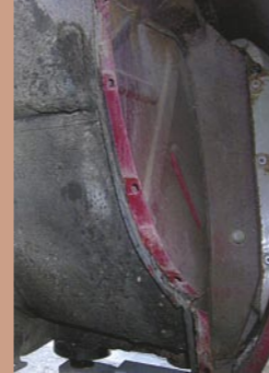
Alter, rissiger Unterbodenschutz vor dem Trockeneisstrahlen.
