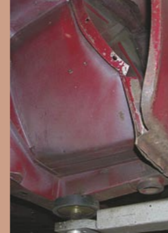
Nach dem Trockeneisstrahlen: Jetzt treten auch bisher nicht sichtbare Roststellen zum Vorschein.
